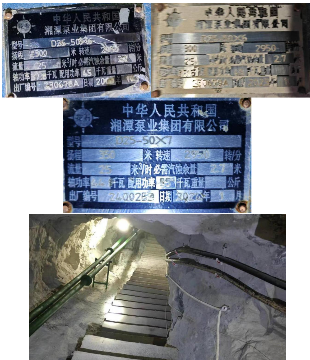
图 2.4-4 水泵型号及排水管路图
